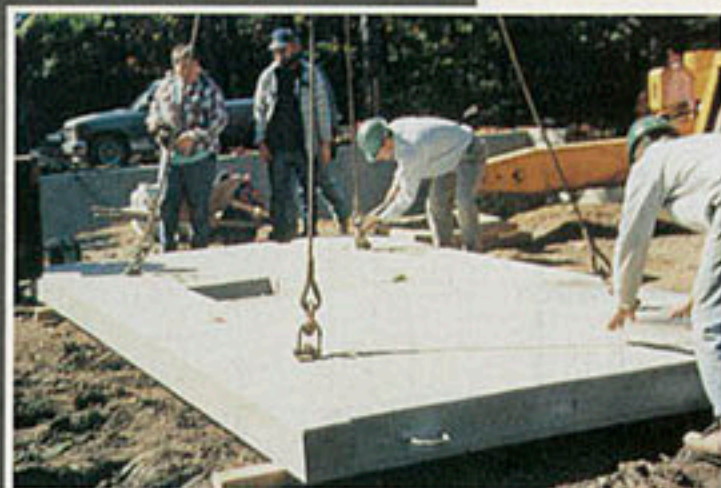
*** 9-10-11, Movimentazione in cantiere dei pannelli prefabbricati; 12-13-14-15, Assemblaggio dei pannelli che non provengono da una produzione standard avendo ciascuno una forma originale ed irregolare.
